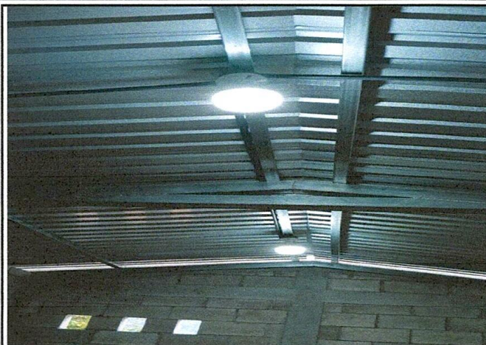
Foto1: CUBIERTA DE LÁMINA Y REPARACIÓN DE SISTEMA ELECTRICO
