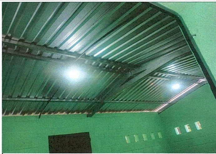
Foto 2: CUBIERTA DE LÁMINA Y REPARACIÓN DE SISTEMA ELECTRICO
